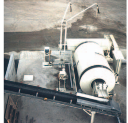
Ejecución con cinta transportadora para la evacuación de sólidos.
